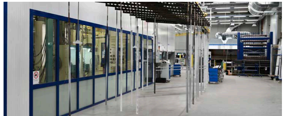
Pulverbeschichtungsanlage in Hagenbach
