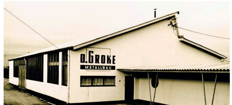
Produktionsgebäude in Jockgrim Karlsruhe
