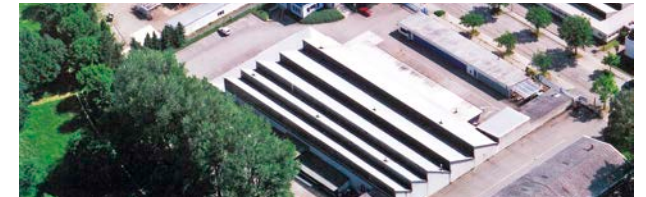
Zusammenführung der Produktionshalle in der Wikingerstraße in Karlsruhe
